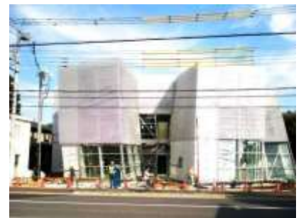
建設中の「なかまちテラス」 2014.10.10 写真提供 : 上田館長
